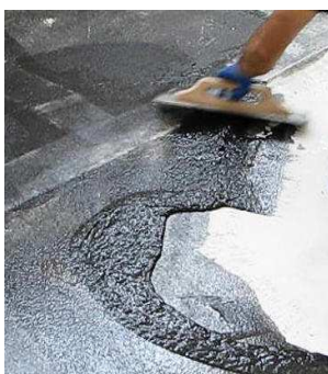
Rasata con filler rinforzante in Fibra di Carbonio.
